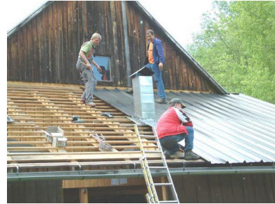
Dacherneuerung FF Stadel
